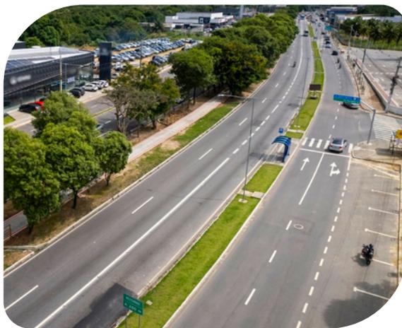
2 novas faixas, calçadas acessíveis, ciclovia, novos sistema de drenagem, rede elétrica e de iluminação em trecho de 2,2 km
